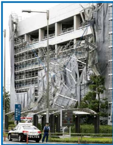
台風の強風によって、東京国際空港(羽田空港)内の工事現場の足場が倒壊した[令和元(2019)年9月の台風第15号](共同通信社提供)
