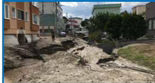
液状化現象により沿岸地域などでは、建物が傾いたり倒れたりします。[北海道胆振東部地震] (寒地土木研究所提供)
